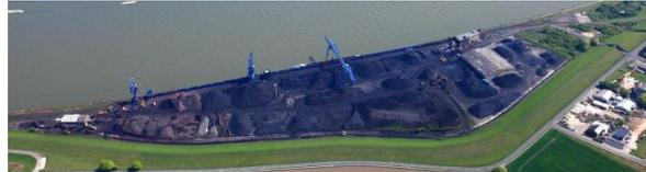
Rheinberg-Orsoy wird an 365 Tagen im Jahr rund um die Uhr gearbeitet. Mit drei Hafenkranen, die bis zu 30 t heben können, ist die Be- und Entladung von Binnenschiffen und Zügen parallel möglich.
